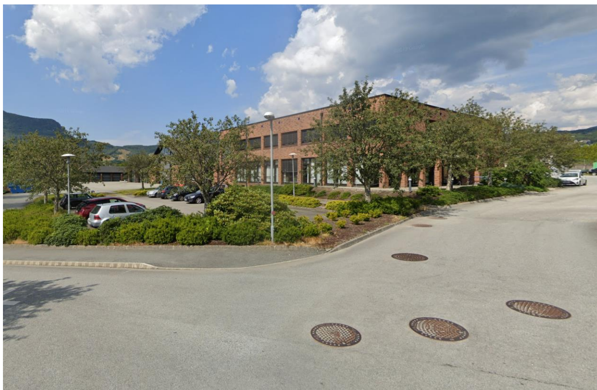
Figur 2 Eksisterende Lysebygg på gnr/bnr 49/631 gir en struktur og retning i området, sett fra Kvalshaugvegen. (kilde: Google maps)
