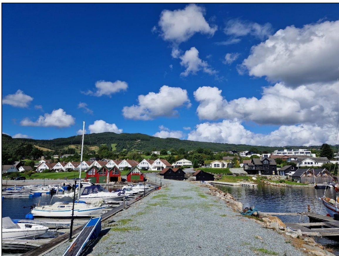
Figur7. Bildet fra molo tatt mot naust og boligbebyggelse nordover.
