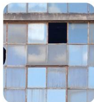
Smårutet vindu (bilde av eksisterende vinduer)
