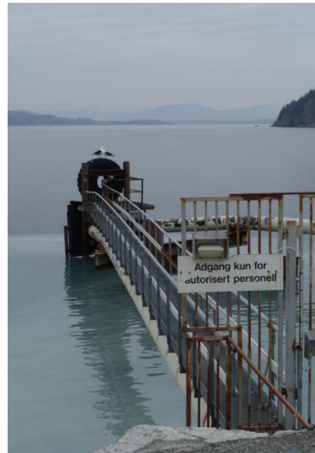
Figur 13: Eksempel på pir for fortøyning av båter, eksisterende kaianlegg.
