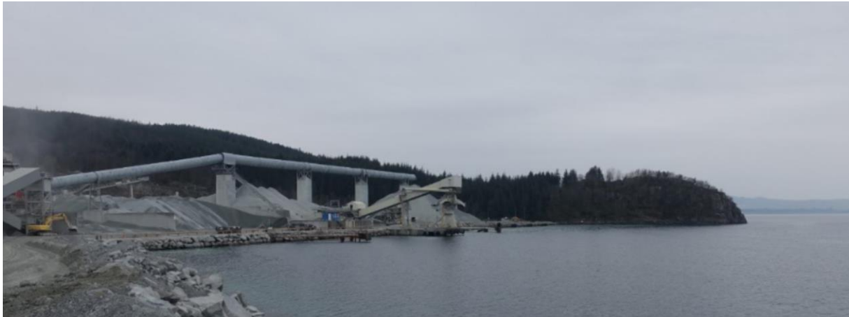
Figur 4: Eksisterende kai med lasteanlegg, Lemensneset i bakgrunnen.
