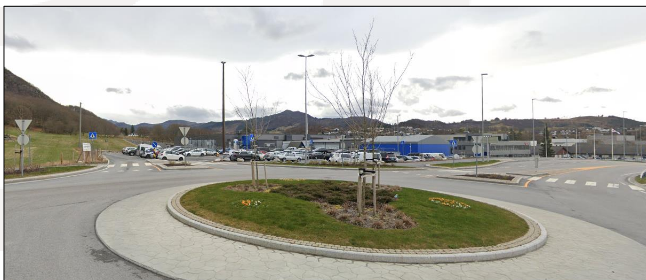
Figur 10: Viser ny, opparbeidet rundkjøring.
