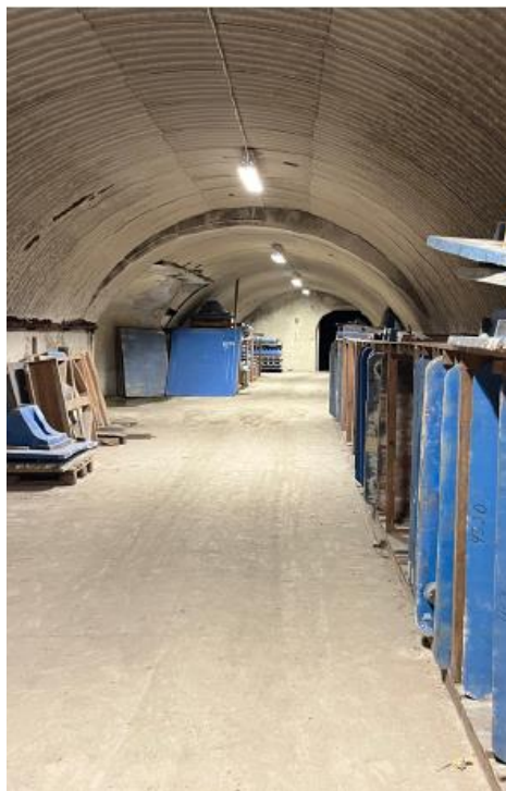
Figur 16 Inne i tilfluktsrommet (Kilde: Kulturminneregistreringen).
