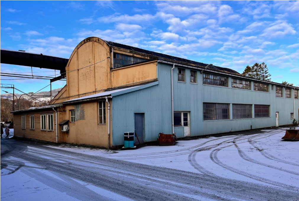
Figur 7 Bygning 17.01 Maskinverkstedet (Kilde: Kulturminneregistreringen).
