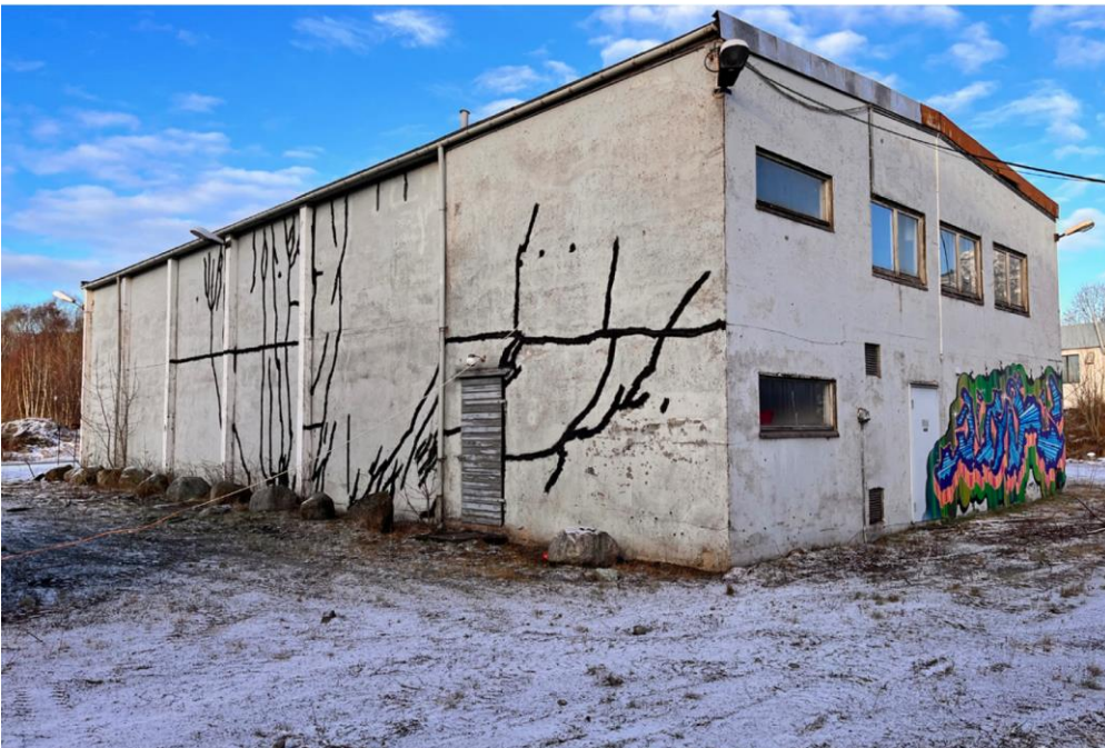
Figur 10 Bygning 20.04 Sekundærstasjon (Kilde: Kulturminneregistreringen).
