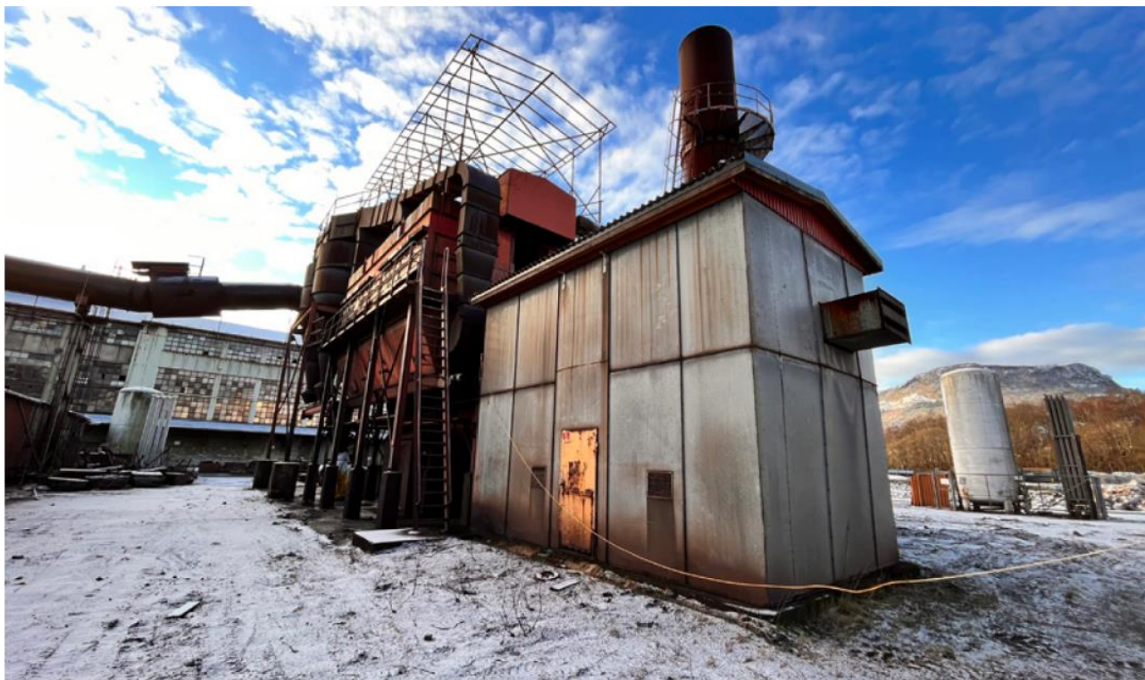
Figur 17 Bygning 39.01 Renseanlegg (Kilde: Kulturminneregistreringen).
