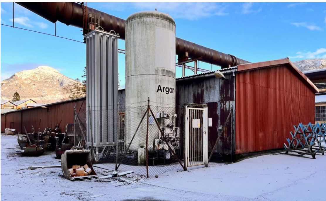
Figur 12 Bygning 23.06 og 23.24 Argon og sandlager (Kilde: Kulturminneregistreringen).
