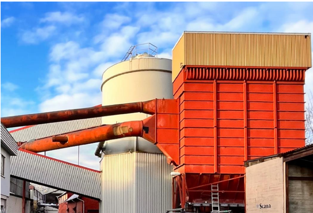
Figur 6 Bygning 11.08 sandanlegg (Kilde: Kulturminneregistreringen).
