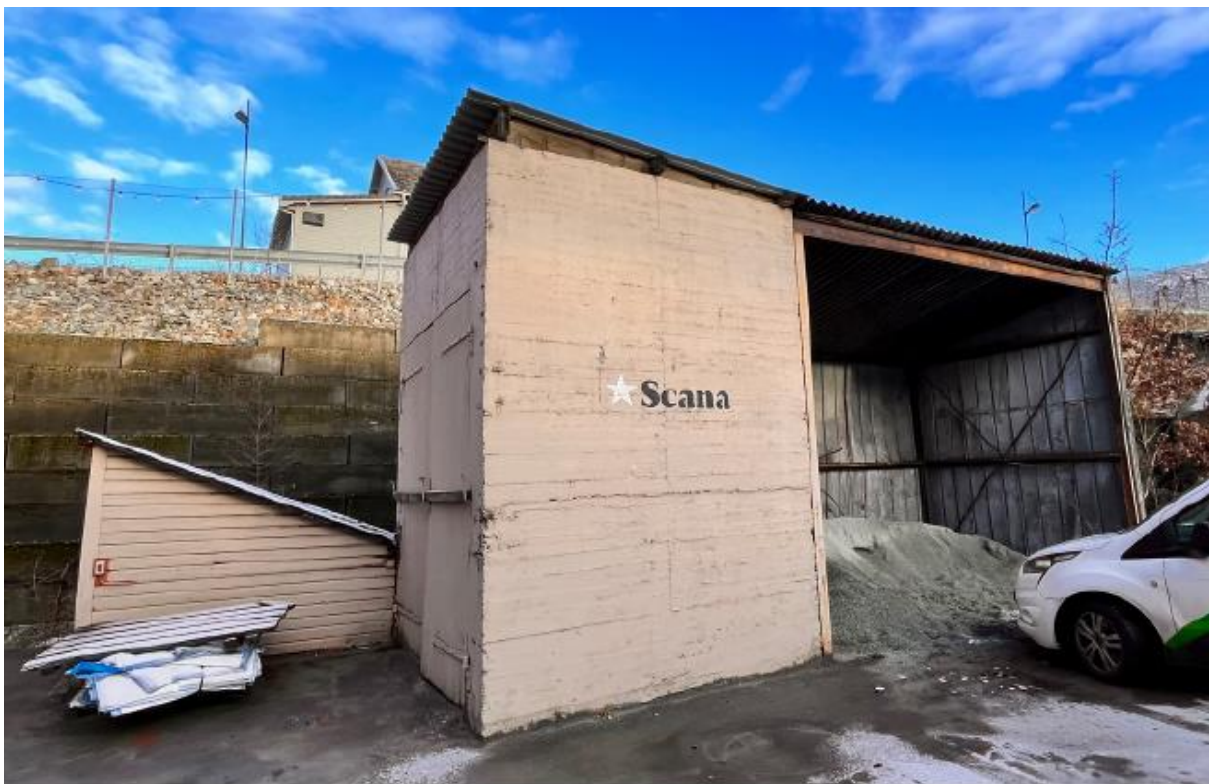
Figur 15 Bygning 27.05 heis/trapp til tilfluktsrom (Kilde: Kulturminneregistreringen).
