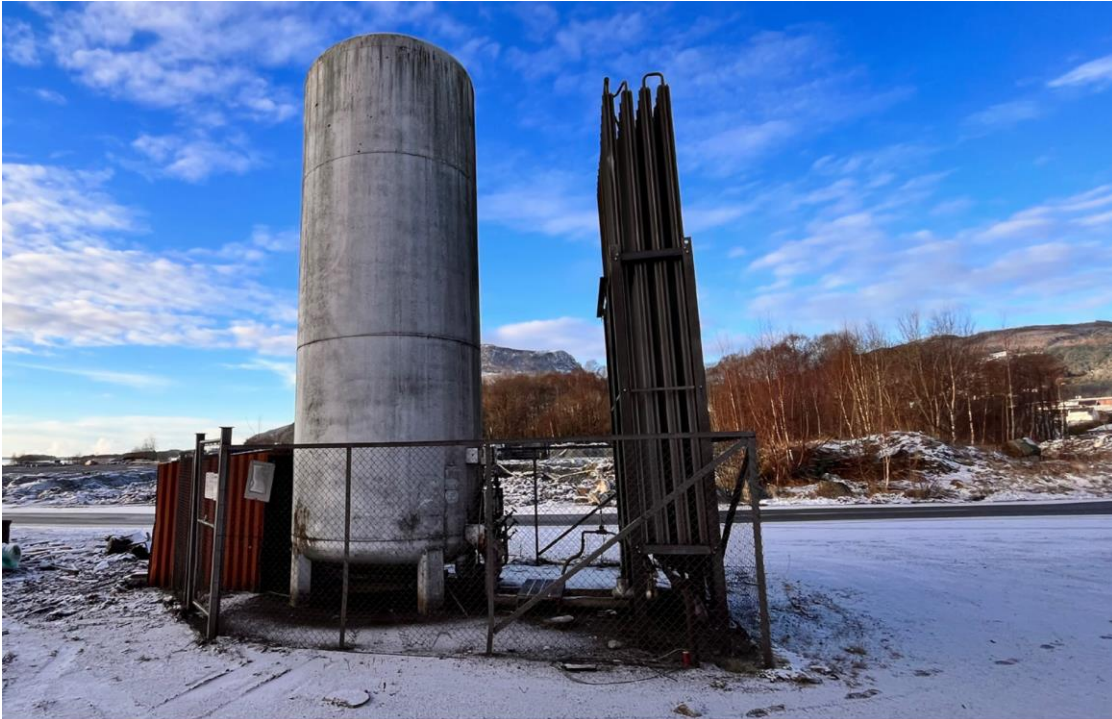
Figur 11 Bygning 23.24 Nitrogentank (Kilde: Kulturminneregistreringen).
